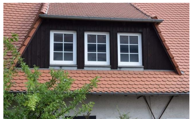
Top saniertes Wohnhaus
