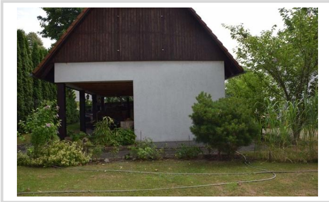
Nebengelass mit Garage
