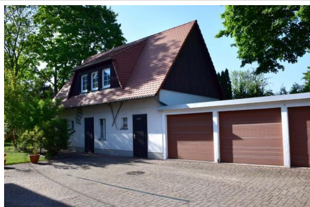
Nebenglass mit Garage
